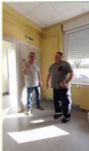
Travaux salle de réunion
