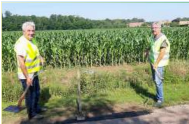
Pose d'enrobé à froid
